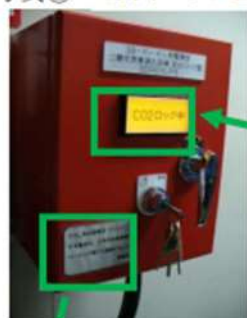
写真③ 放出ロック盤
