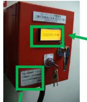
写真③ 放出ロック盤
