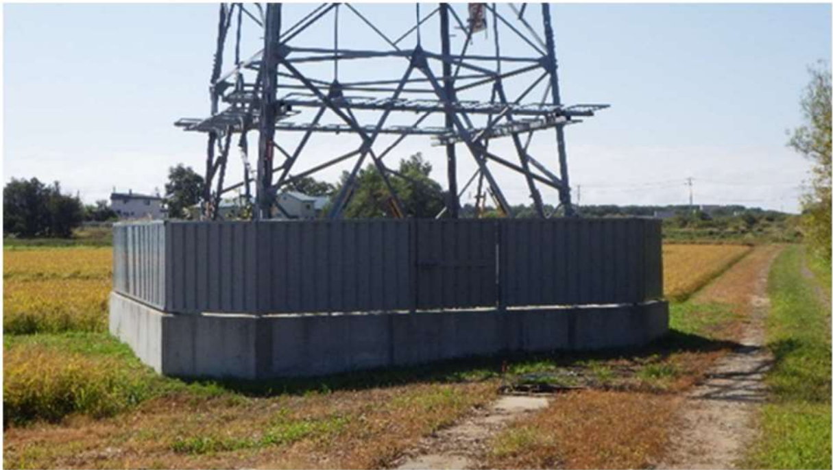
第 1.2 図 浸水予測範囲内にある送電線鉄塔の現地状況
