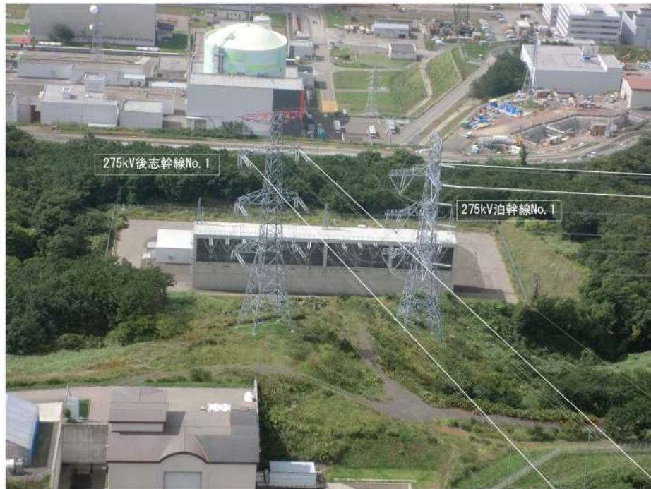
第 2.2.3.3 図 ①近接箇所の現地状況 (1/3)
