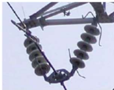
第2.2.4.8図 懸垂碍子化の施工状況
