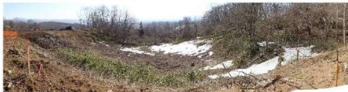
P3 防災科研調査において地滑り土塊とされる斜面の状況 防災科研調査において滑落崖とされる箇所から、地滑り土塊とされる箇所を見下ろす。 地滑り土塊を示唆する凹凸に富む緩斜面は認められない。
