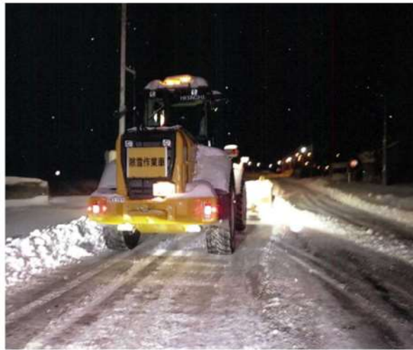
第4-2図 重機による除雪作業（2）
