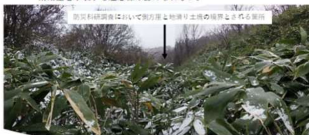
P2 防災科研調査において側方崖と地滑り土塊の境界とされる箇所の状況 沢を挟んだ両岸において、斜面の角度が同程度となっており、側方崖を示唆する 特徴である。地滑り土塊とされる箇所に向かう明瞭な急傾斜は認められない。
