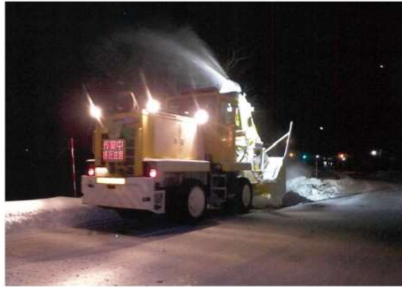
第4-1図 重機による除雪作業（1）
