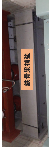
鉄骨梁補強箇所(天井パネル内)
