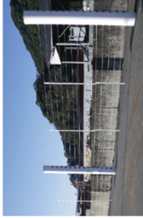
津波漂流物防護柵の設置イメージ
