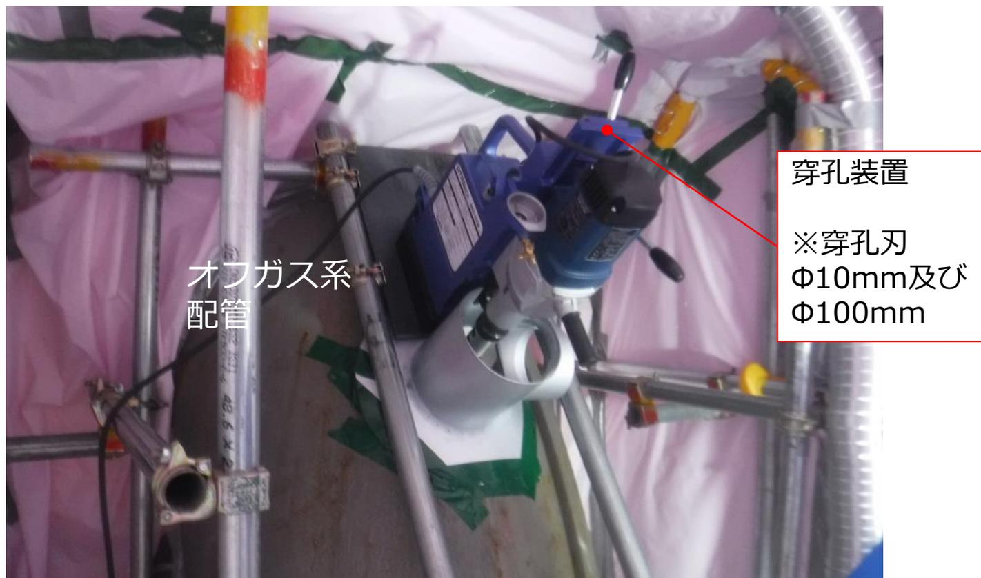
オフガス系配管の穿孔装置設置状況 (1/2号機排気筒内部調査時)
