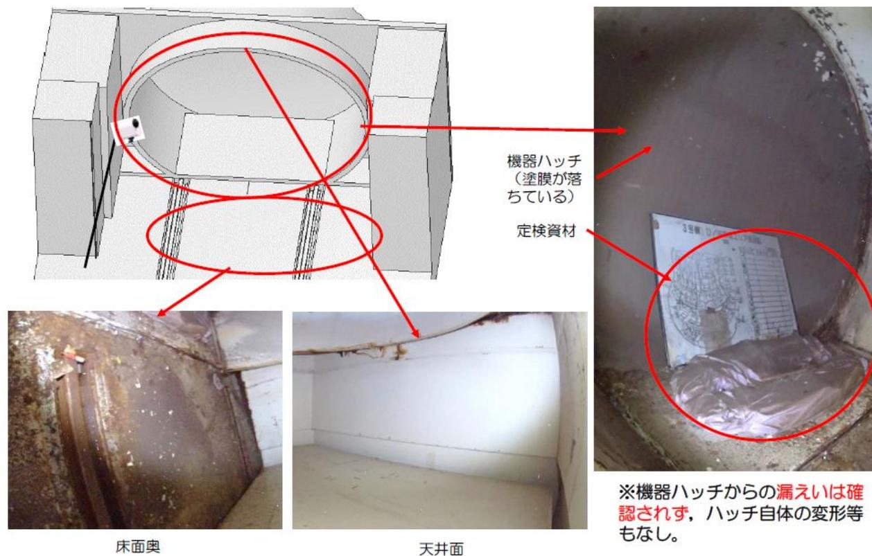
図 4-4 機器ハッチの写真<sup>[37]</sup>
