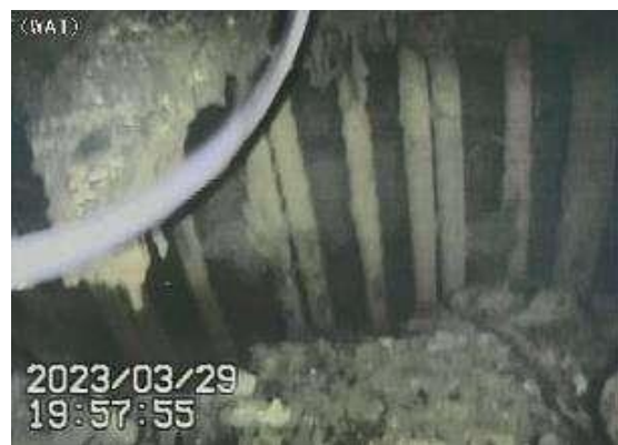
鉄筋漏出部直上にある2層目の棚状堆積物？
