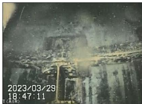
サポートプレートと残存するレイル
