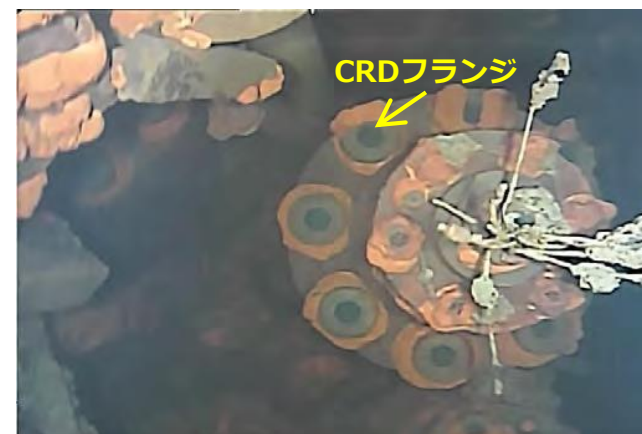
写真3. 3号機で確認されたCRD
