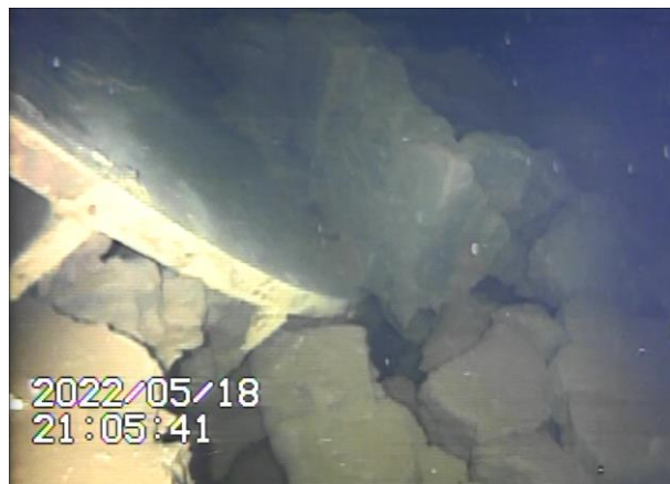
ジェットデフレクター面から剥がれた堆積物
