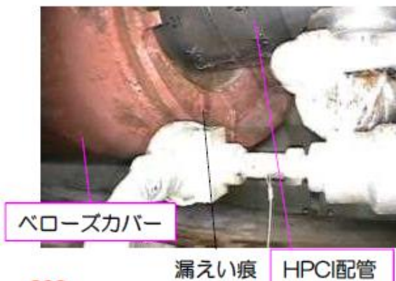
写真①：X-53ベローズカバー接続部
