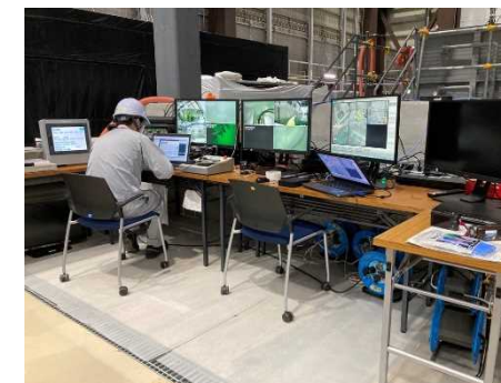
遠隔操作室の外観
