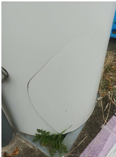
機器更新時に筐体の破損を発見 内部に異常がないため養生後、更新作業を実施
