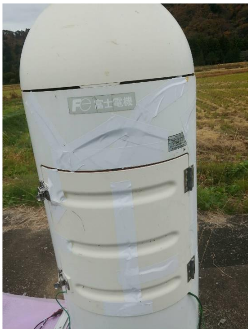
機器更新時に筐体の破損を発見 内部に異常がないため養生後、更新作業を実施
