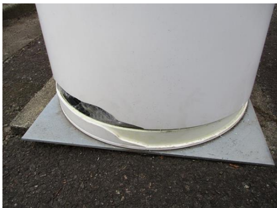
車両接触による筐体破損
