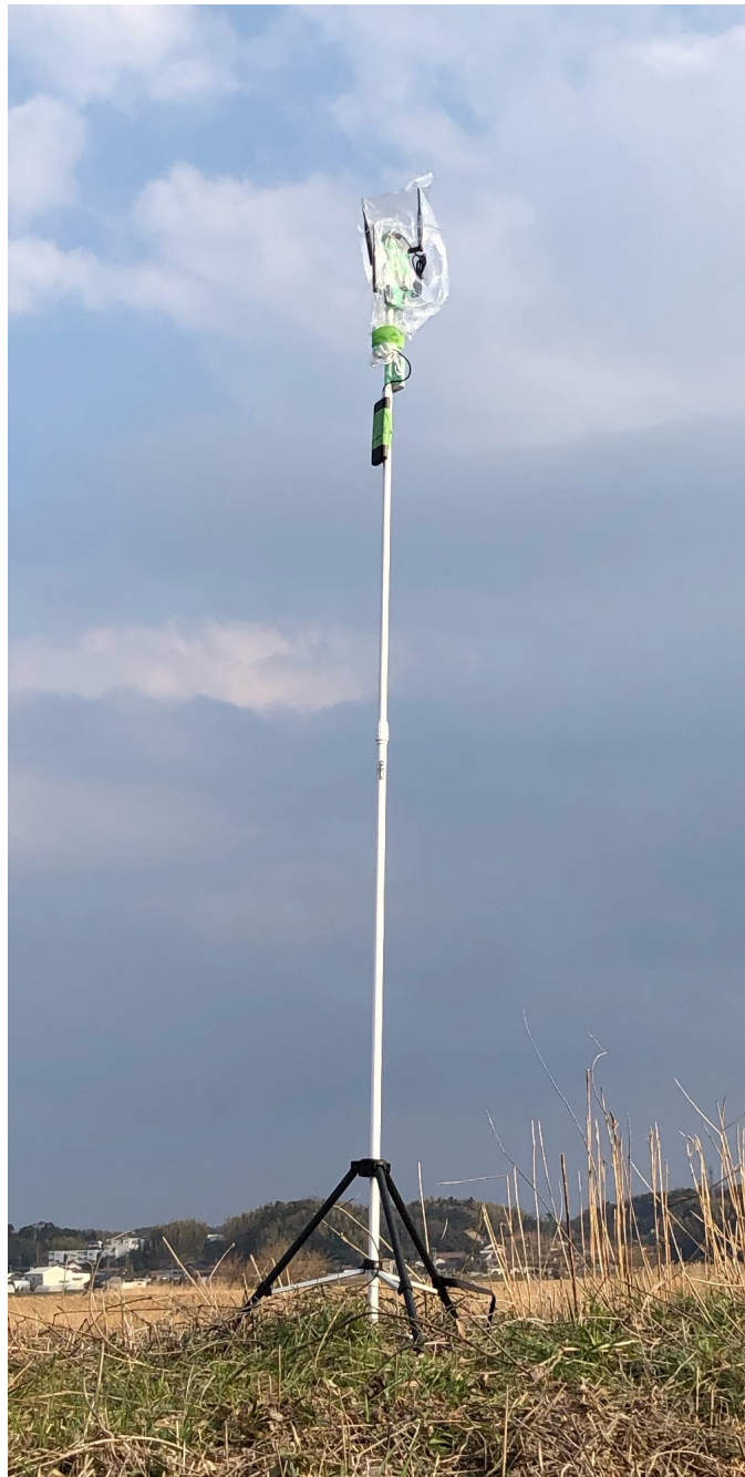
図 11 中継点に設置した中継局の様子。高さ 2 ～ 2.5 m となるように設置された。
