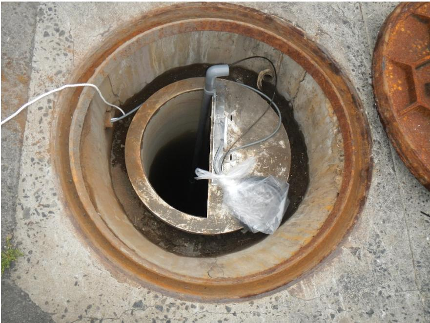
図 2-2-27. 二俣潮位観測点観測井内。中央上の塩ビパイプ内にセンサーを装着している。
