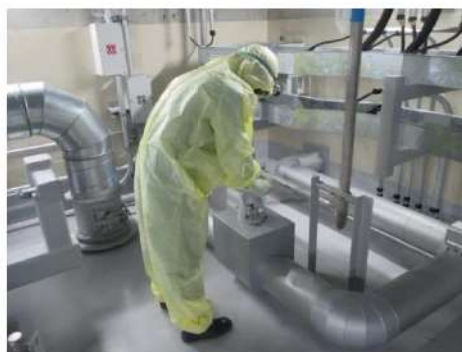
RHRS-CSS 連絡ライン手動弁操作 （原子炉補助建屋 T. P. 10. 3m（中間床））
