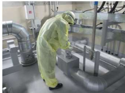
RHRS-CSS 連絡ライン手動弁操作 (原子炉補助建屋 T.P. 10.3m (中間床))
