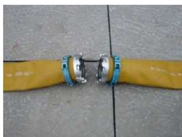
可搬型ホース(150A)接続前
