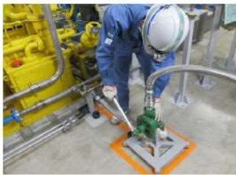
潤滑油供給操作 （周辺補機棟 T. P. 10. 3m）
