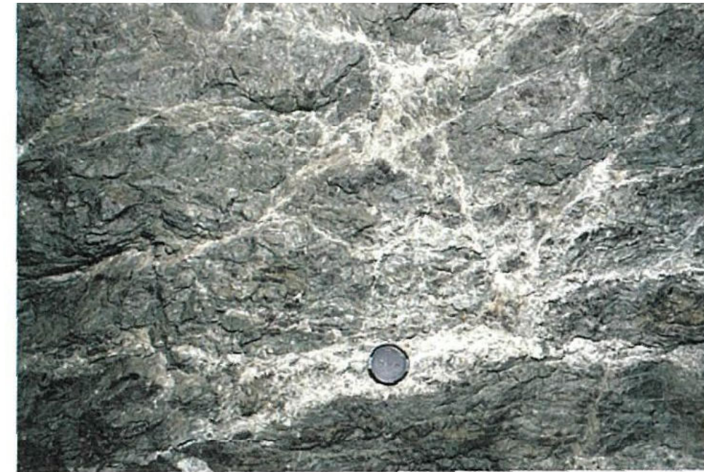
写真-2.7 中・古生代の緑色岩の熱水変質(多数の不規則な節理沿いに熱水変質を受けて網目状に白色の粘土脈が分布しており、強度は粘土脈の分布しない部分と比較して1ランク以上劣る)
