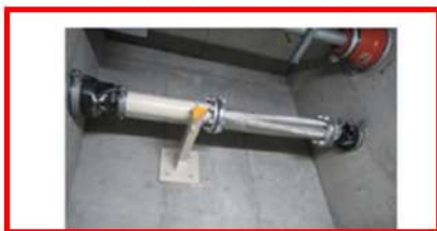
第1-35図：地盤変位対策の実施例
