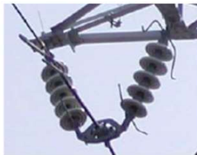
第2.2.4.8図 懸垂碍子化の施工状況
