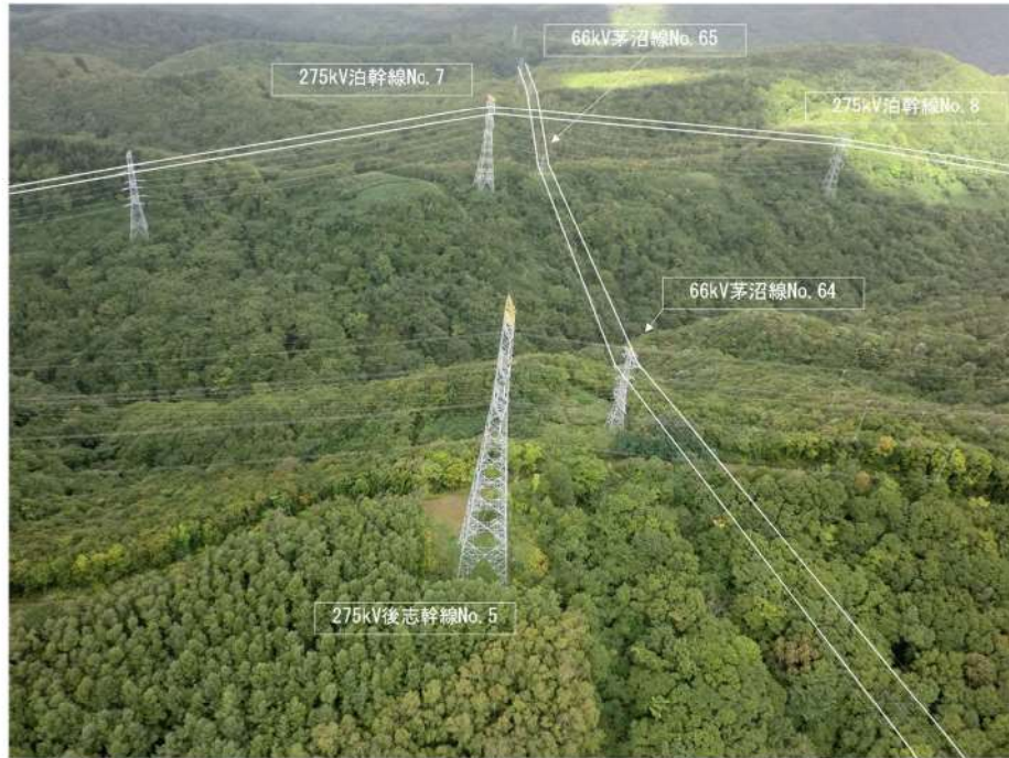
第 2. 2. 3. 5 図 ③交差箇所の現地状況 (1/3)
