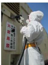
可搬型代替電源車の給油口へのホース接続（クイックカップラ式） （可搬型代替電源車） （屋外）
