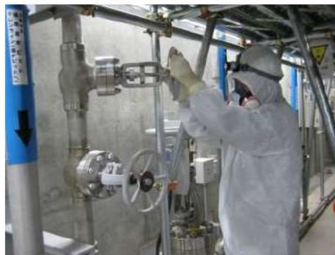
補助給水ピット供給 ライン系統構成 (周辺補機棟 T. P. 24. 8m)
