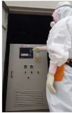
代替非常用発電機起動 (屋外)
