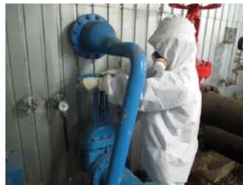
ろ過水タンクからの補給（屋外） （作業風景は類似作業）
