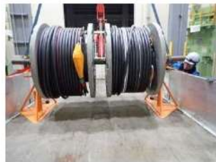
号炉間連絡予備ケーブル
