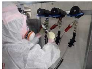
号炉間連絡予備ケーブル接続（端子） （屋外） （作業風景は類似作業）
