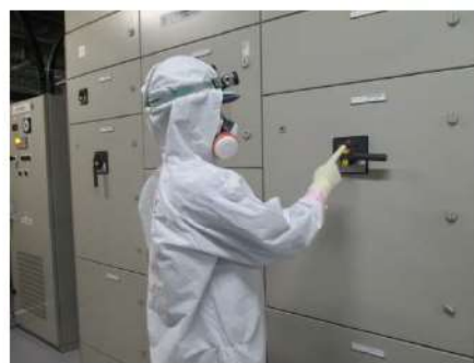
可搬型直流電源用発電機及び 可搬型直流変換器による受電操作 （安全補機開閉器室） （原子炉補助建屋T. P. 10. 3m）
