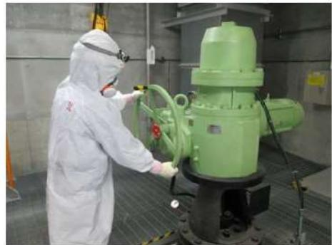
主給水隔離弁閉止操作
