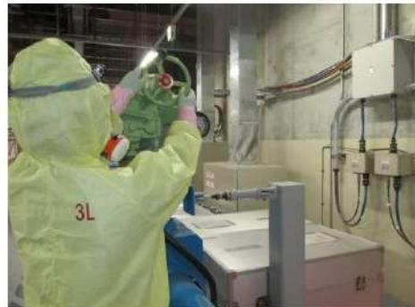
格納容器隔離弁閉止操作
