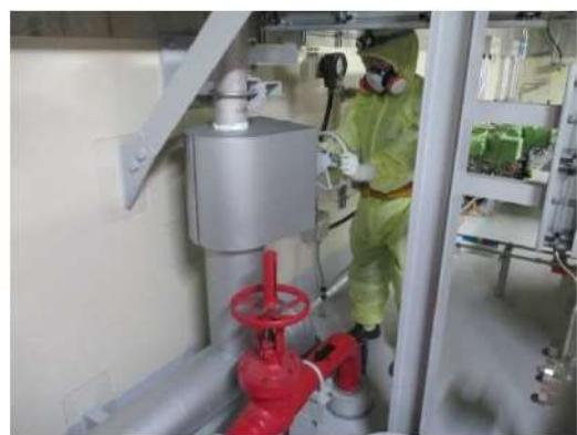
代替格納容器スプレイポンプ系統構成
