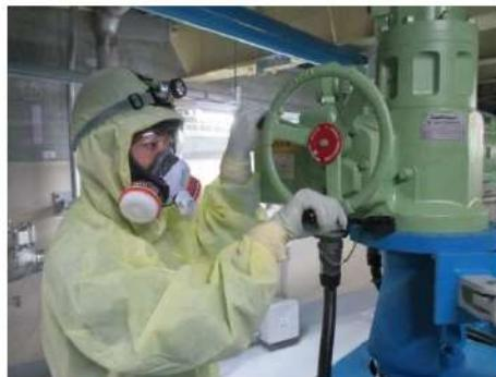
1次冷却材ポンプ封水ライン隔離弁
