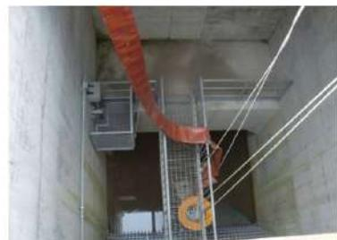
海水取水箇所への水中ポンプ設置
