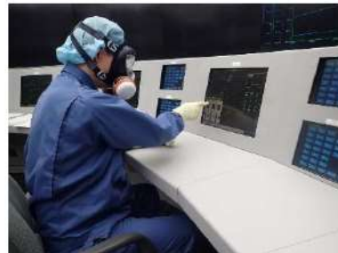
主蒸気逃がし弁開操作 （中央制御室）
