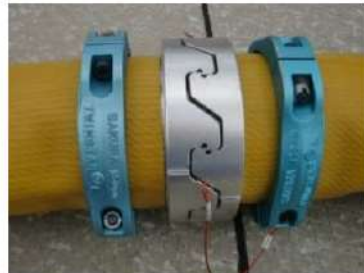
可搬型ホース（150A）接続後
