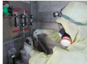
加圧器逃がし弁操作用 可搬型窒素ガスボンベ 供給操作 (周辺補機棟 T.P. 17.8m)
