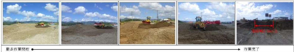
第5図 土砂撤去状況写真
