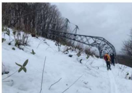
大雪による鉄塔倒壊事例 ※3
