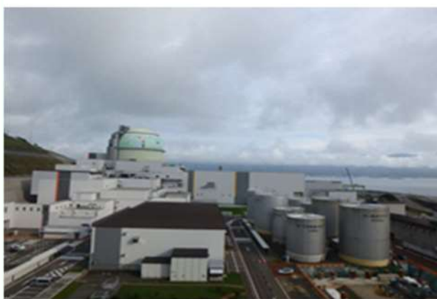
2号炉タービン建屋屋上
