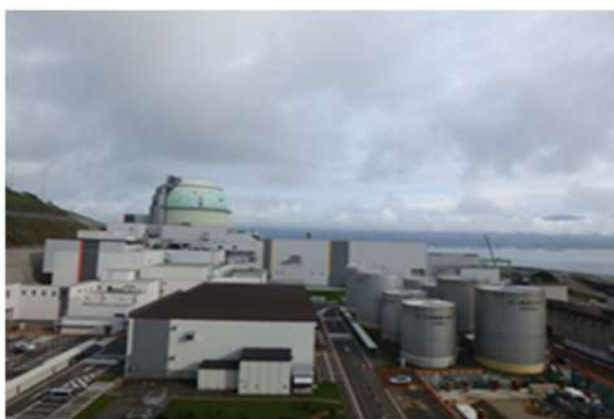
2号炉タービン建屋屋上
