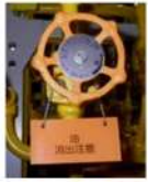
油類に係る弁 弁の識別
