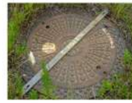
マンホール蓋
