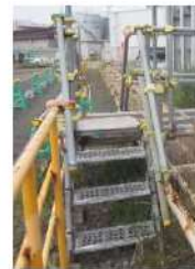
階段（単管パイプ製）
