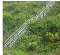
階段（単管パイプ製）
