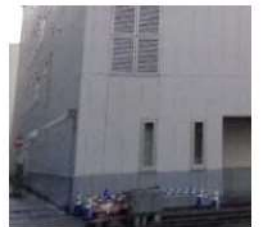
外壁 (セメント板)
