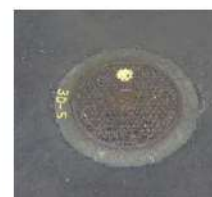
マンホール蓋
