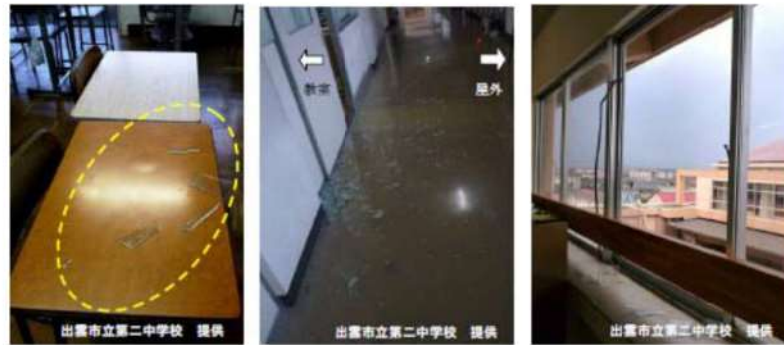
(1) 教室 (2) 廊下 (3) 屋外に面した窓ガラス
