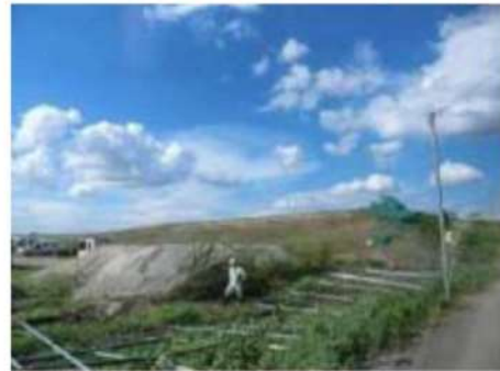
フェンスの被害
