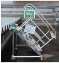
階段（単管パイプ製）
