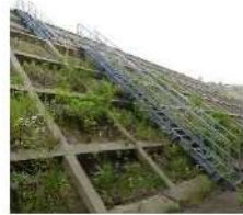
階段（H鋼製）
