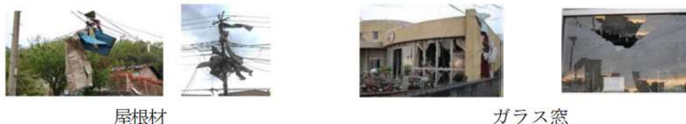
図1 平成24年5月6日 茨城県つくば市で発生したF3竜巻による建築物の被害状況※1
