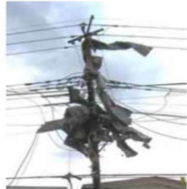
飛散した折板屋根の状況
