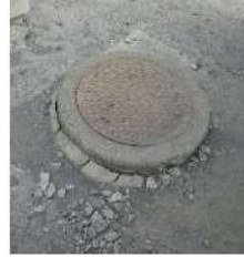
マンホール蓋
