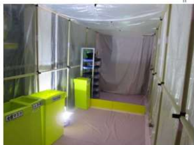
可搬型照明①
