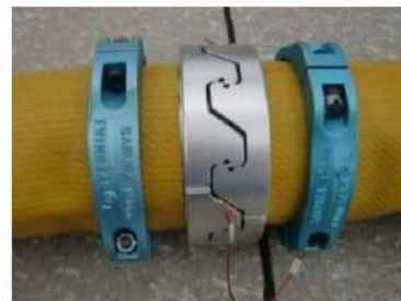
可搬型ホース（150A）接続後
