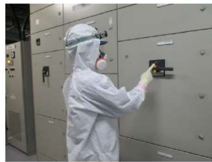
可搬型直流電源用発電機及び 可搬型直流変換器による受電操作 （安全補機開閉器室） （原子炉補助建屋T.P.10.3m）
