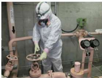
燃料補給系統構成 (ディーゼル発電機室) (ディーゼル発電機建屋T.P. 6. 2m)
