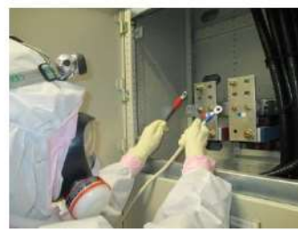
可搬型直流変換器 直流出力ケーブル接続(端子) (安全補機開閉器室) (原子炉補助建屋T. P. 10. 3m)
