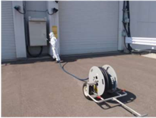
高圧ケーブル敷設 (屋外)
