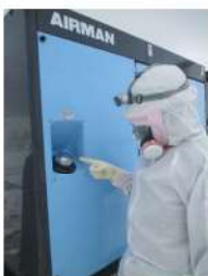
可搬型直流電源用発電機 給油口 （可搬型直流電源用発電機） （屋外）
