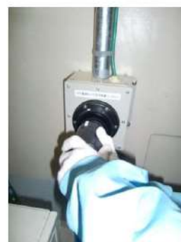
電源ケーブル接続
