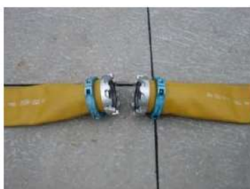
可搬型ホース(150A)接続前
