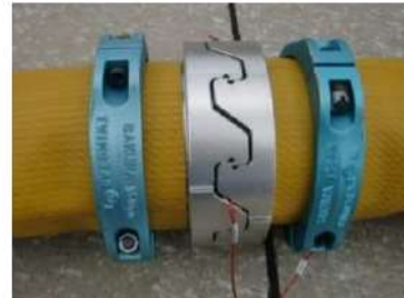
可搬型ホース (150A) 接続後
