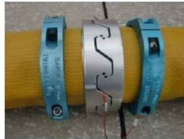
可搬型ホース(150A)接続後
