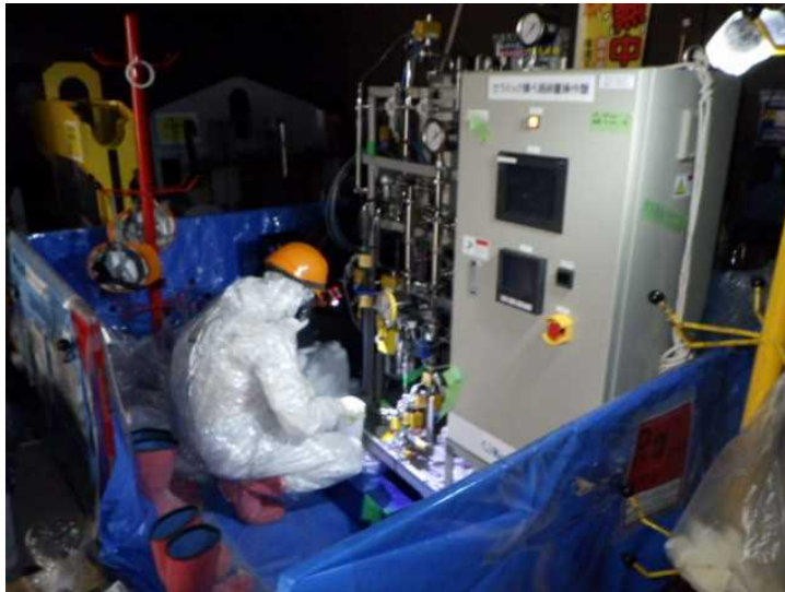
フィルタ通水試験装置写真
