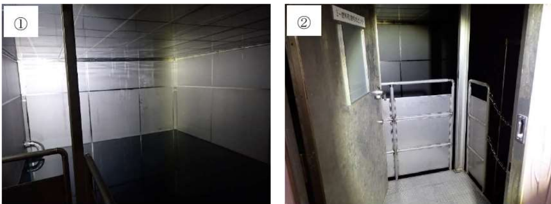
第 5-4 図：燃料取替用水ピット室イメージ及び現場状況
