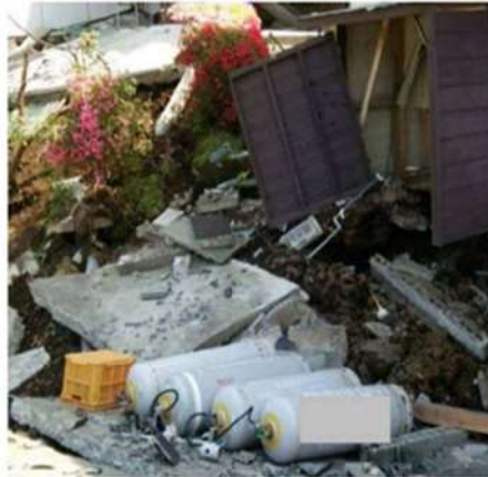
熊本地震でのLPガスボンベの被災状況の一例 3)
