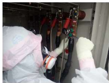
号炉間連絡ケーブル接続 （屋外）
