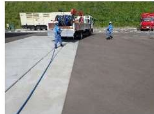
号炉間連絡予備ケーブル敷設 （屋外）
