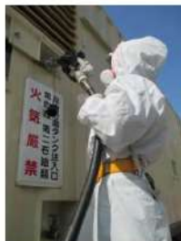
可搬型代替電源車の給油口への 接続 (クイックカップラ式) (可搬型代替電源車) (屋外)
