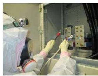
可搬型直流変換器 直流出力ケーブル接続作業 (安全補機開閉器室) (原子炉補助建屋T. P. 10. 3m)
