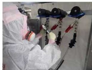
号炉間連絡予備ケーブル接続 （屋外） （作業風景は類似作業）
