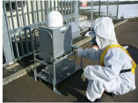
②可搬型モニタリングポスト設置
