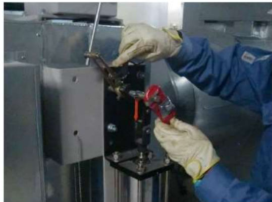
(空気作動ダンパ開又は閉作業イメージ)
