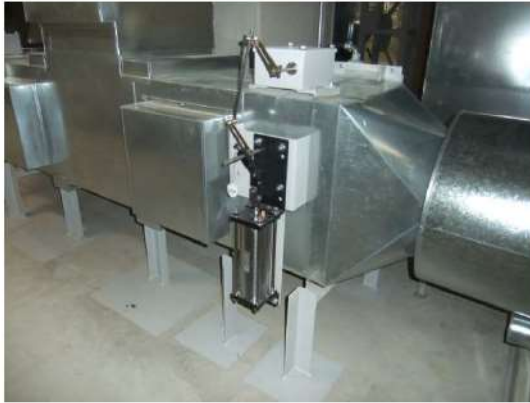
ダンパ全景 (原子炉補助建屋T.P. 24.8 m) (開操作対象ダンパの一例)
