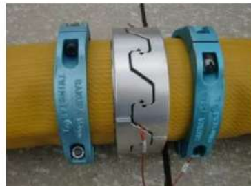
可搬型ホース(150A)接続後
