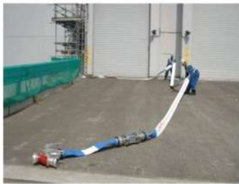
可搬型ホース敷設 （屋外）
