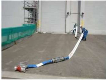
可搬型ホース敷設 (屋外)
