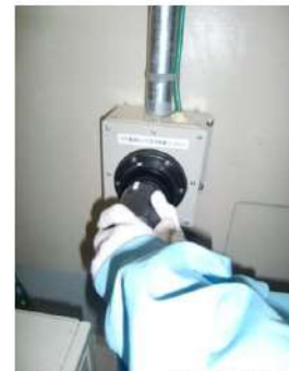
電源ケーブル接続
