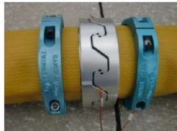
可搬型ホース(150A)接続後
