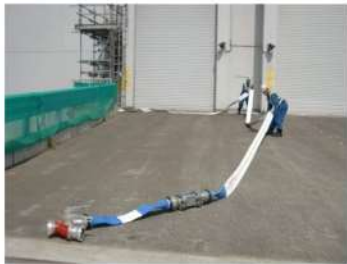
可搬型ホース敷設 （屋外）
