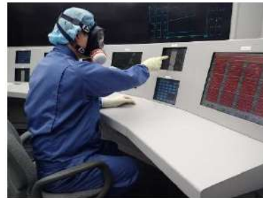
加圧器逃がし弁開操作 （中央制御室）
