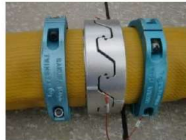
可搬型ホース(150A)接続後
