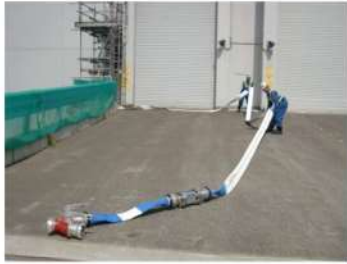
可搬型ホース運搬 (屋外) (作業風景は類似作業)
