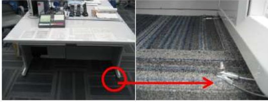
図10 運転員机の固定
