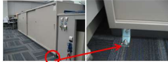
図11 キャビネットの固定
