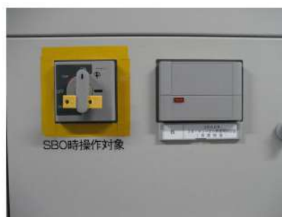
図 14 操作対象機器への反射テープ貼り付け例
