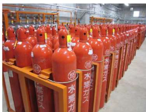
2号炉発電機ガスボンベ庫
