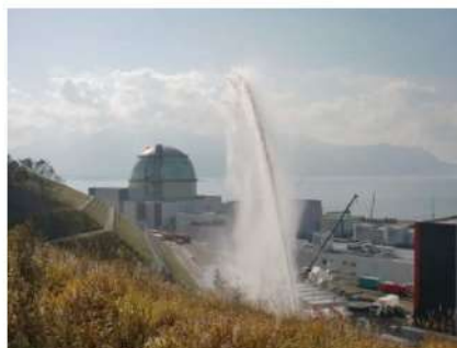
第2図 直線状放射による放水状況
