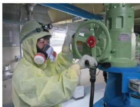
1 次冷却材ポンプ封水ライン隔離弁 閉止操作 （周辺補機棟 T.P. 17.8m（中間床））
