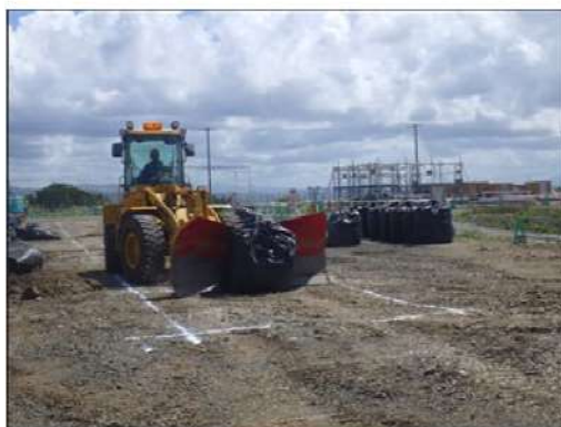
図4 がれき撤去訓練
