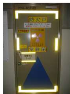
図 16 扉への反射テープ貼り付け例
