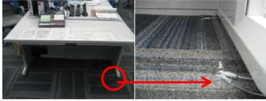
図10 運転員机の固定
