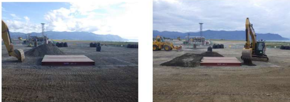
第10図 段差復旧状況
