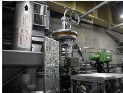
【図1 3B-主蒸気逃がし弁】
