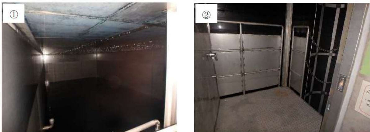
第 41-4-7 図：補助給水ピットの現場状況
