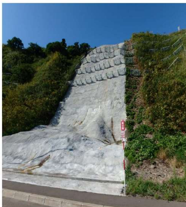
図 1 防火帯モルタル吹付工の施工例
